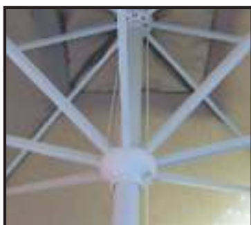
Sistema de apertura por polea y bloqueo de seguridad con pasador. Pulley system with safety pin lock. Système de poulie, avec goupille de sécurité.
